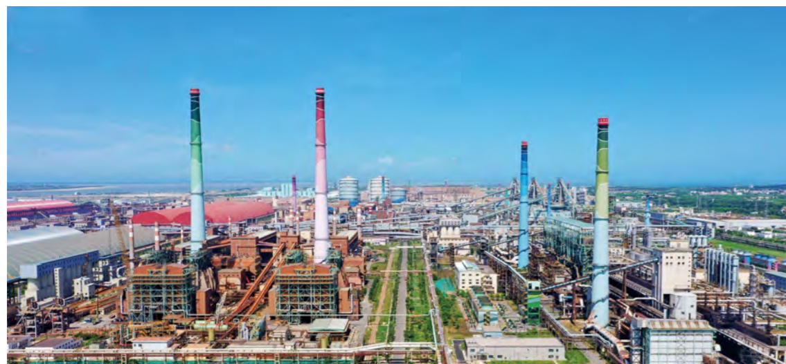
建设银行助推宝武绿碳基金落地，图为中国宝武钢铁会博中心工业遗存保护与活化再利用项目
