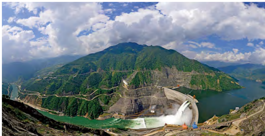
建设银行华能水电承销可持续债券，图为本期债券募投项目的小湾水电站
