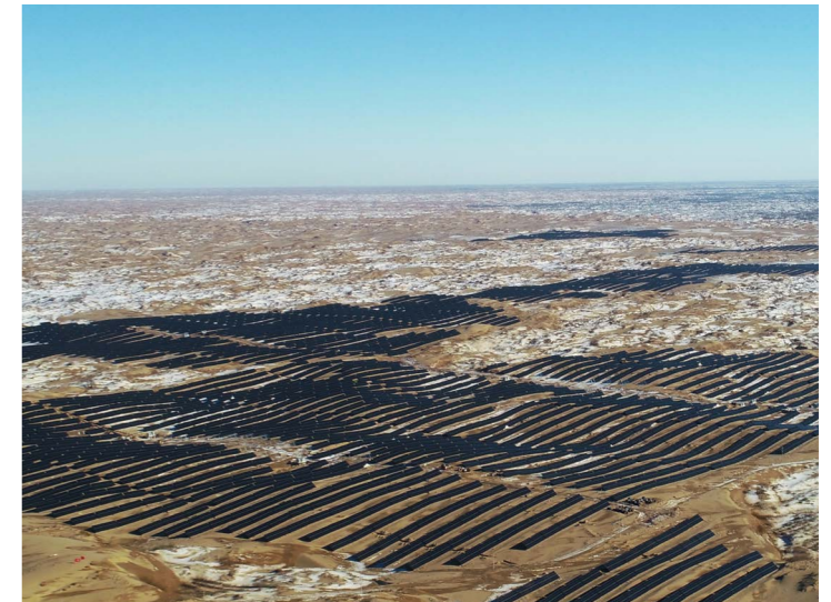
内蒙古自治区分行信贷支持的光伏治沙项目
